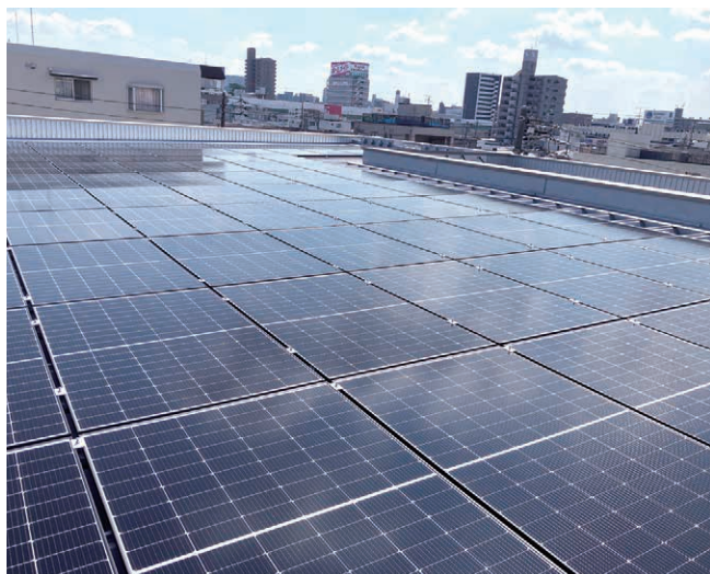
名古屋営業所の屋上の様子
